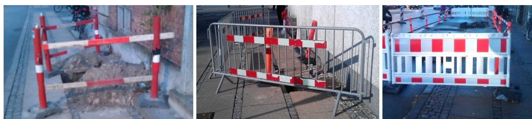
Figur 4.10 Eksempler på tværafspærring på fortov.
