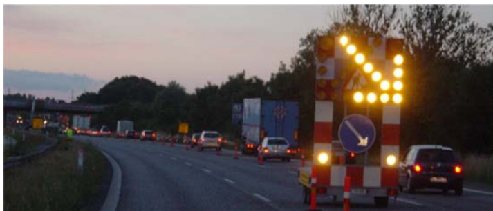
Figur 7.32 Eksempel afspærringsvogn med tændt lyspil og bundblink.
