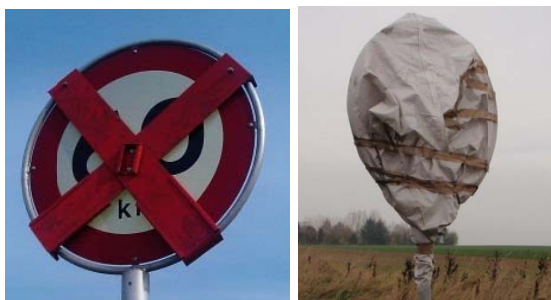
Figur 4.3 Eksempler på annullering af færdselstavler.
