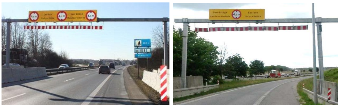
Figur 7.52 Eksempler på højdevarslingsportaler med metalplader (rasleplader).
